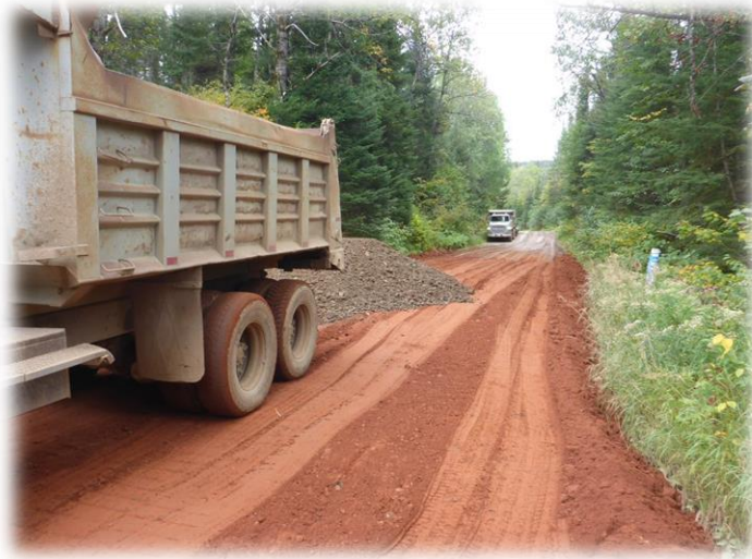
Aménagement de sentier sur la rivière Cascapédia
