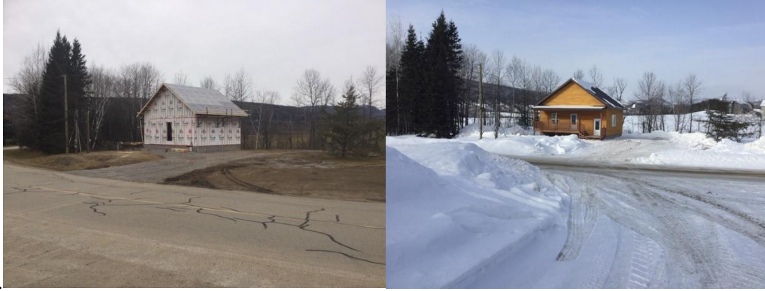
Bâtiment d'accueil de la rivière du gouffre avant/après
